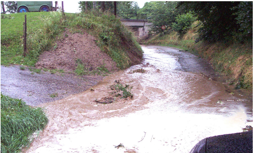
Unwetter und Sturmschäden 2001
