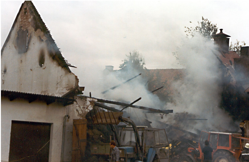
Brand Scheune und Hopfendarre (Bergmeister „Huber“)
